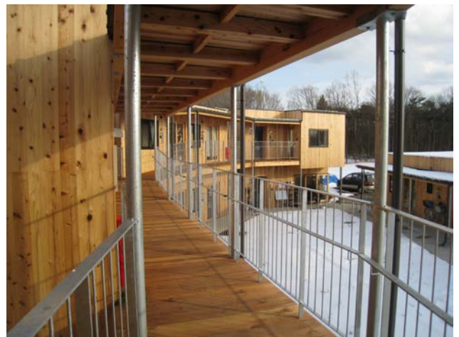
【2階の外廊下から】
